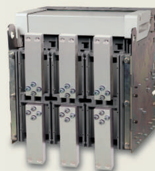
Выводы для присоединения шин спереди
